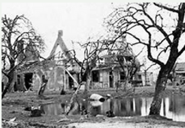
Afbeelding 8 Schade Boerderij De Dobbelaere, IJzendijke
