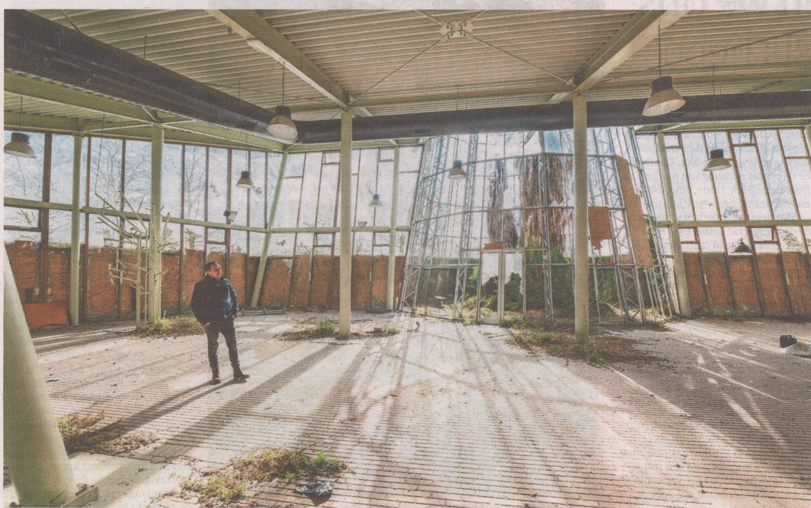
Eric van Damme in het ontakelde gebouw van Euregiotuinen. FOTO'S BOAZ TIMMERMANS
